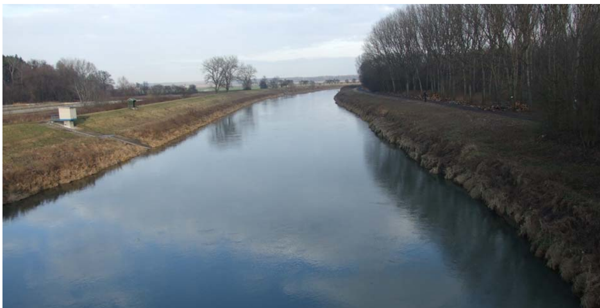
Obrázek 14: Upravené koryto Moravy u Strážnice
