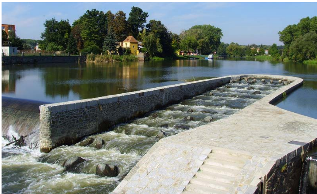
Obrázek 22: Rybochod (rybí přechod) na jezu Břeclav na Dyji
